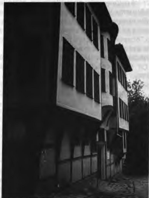
Пловдив – къщата на Георгиади – фасада
